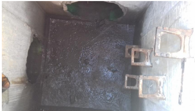
Slika 5.6. Separator Južna obilaznica (18.05.2017)
