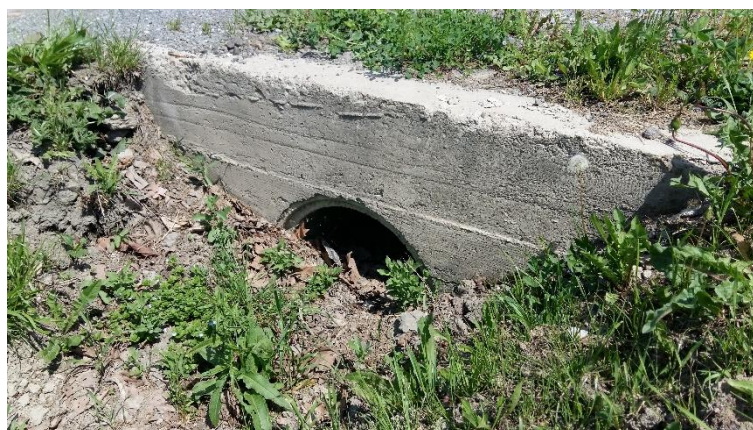
Slika 5.5. ŽC 4085 Željeznička ulica (04.05.2017)
