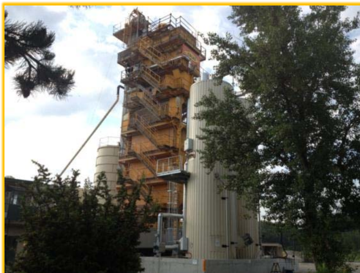
Slika 5-3: Asfaltna baza Motičnjak u Varaždinu (COLAS Hrvatska d.d.)
