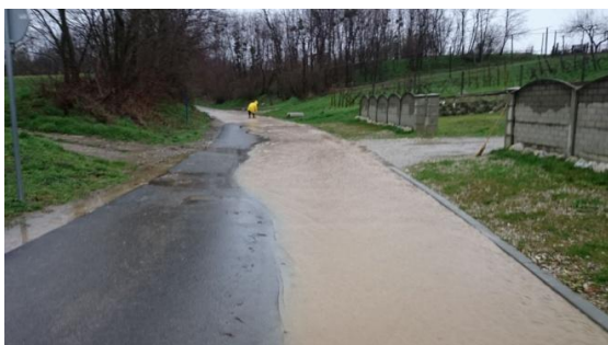
Slika 6. Voda na cesti
