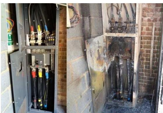
Slika 1. Posljedice električnog luka na električnim instalacijama [1]
