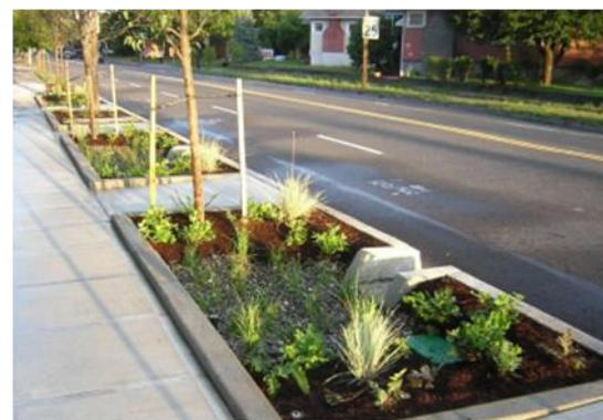
Slika 4. Bioretencijsko područje i detalj odvoda vode s kolnika [8]
