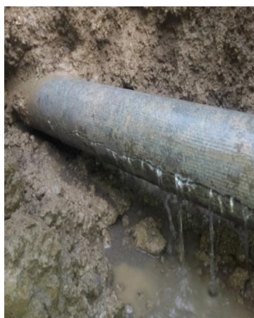
Slika 5. Vidljivo curenje - puknuće azbestno cementne cijevi 15.11.2017., godine u Ulici Zinke Kunc Belišće, puknuta i sanirana azbestno cementna cijev
