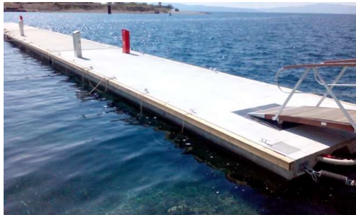
Slika 10. Primjer hodne površine na pontonu: a) drvena hodna površina, b) beton
