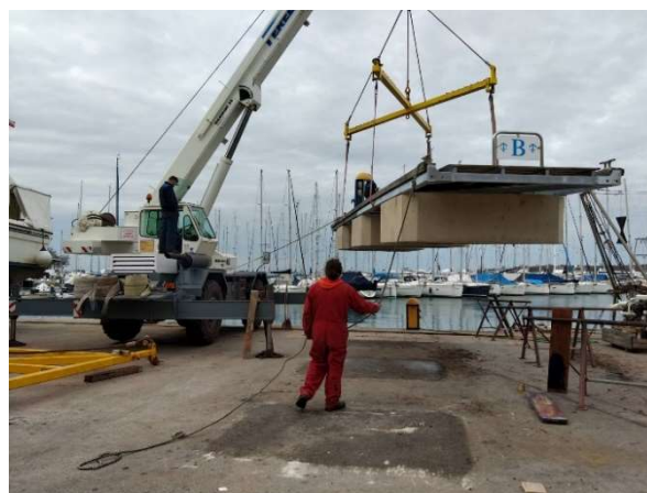
Slika 11. Primjer zamjene oštećenog betonskog uzgonskog elementa i čeličnog okvira
