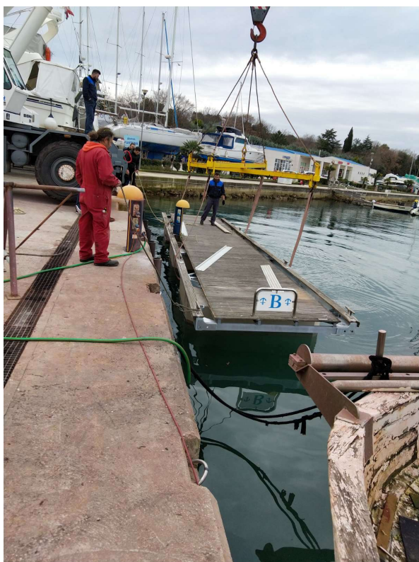
Slika 11. Primjer zamjene oštećenog betonskog uzgonskog elementa i čeličnog okvira
