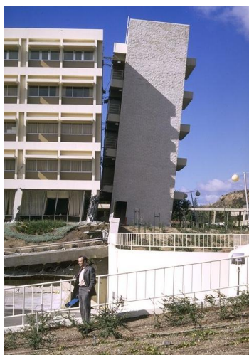
Slika 4. Zgrade bolničkog kompleksa Olive View nakon potresa San Fernando 1971: nagnuće zgrade zbog sloma u temeljnom tlu (Steinbrugge, 1971)
