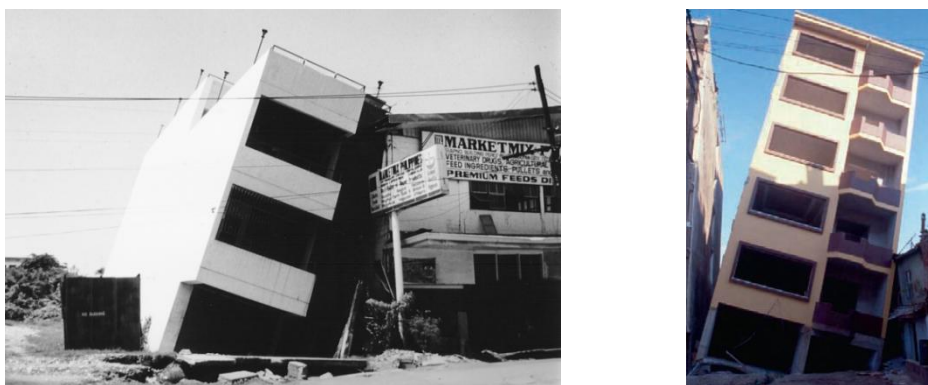
Slika 26. Zgrade bez vidljivih konstrukcijskih oštećenja koje su se nagnule zbog plastifikacije temeljnog: lijevo posljedica potresa koji je pogodio Filipine 1990. (Zeng i Steedman, 1998) i desno posljedica potresa Kocaeli iz 1999. (Fardis, 2009)
