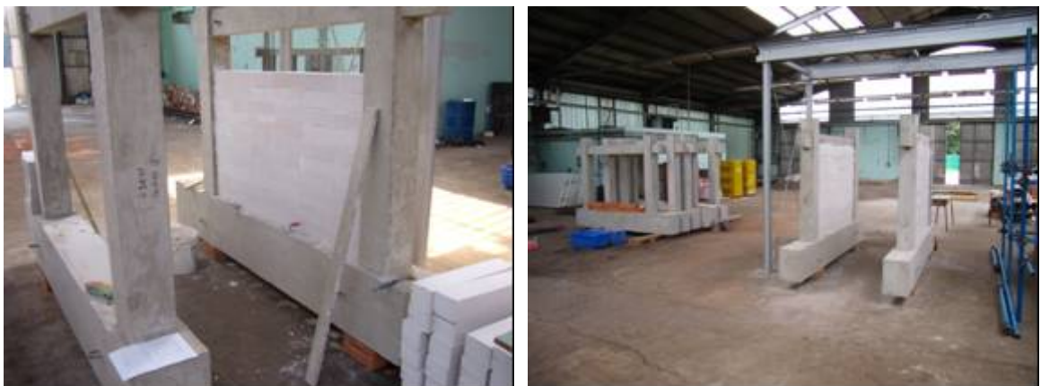
Slika 4.6 Prikaz zidanja zidnog ispuna od porobetonskih blokova MO2,5
