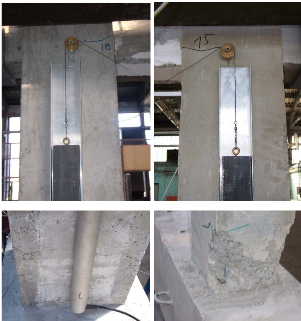
Slika 4.42 Prikaz pukotina na MODELU 10
