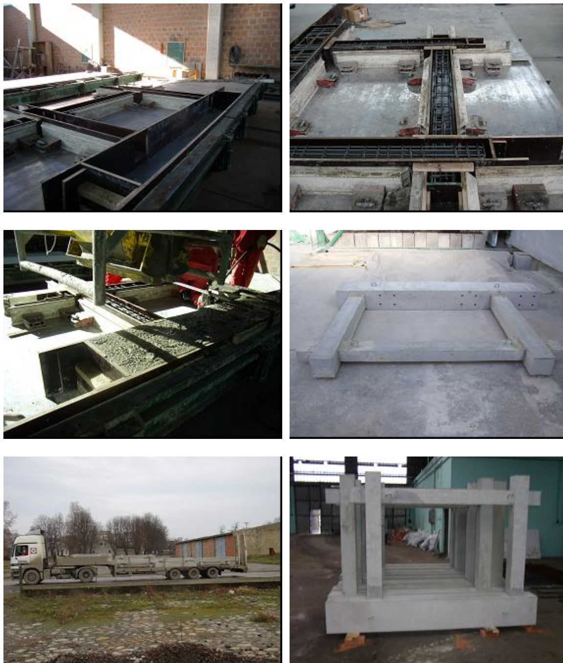
Slika 4.3 Prikaz izrade i dopreme armirano-betonskih okvira modela
