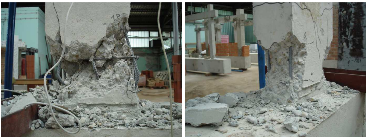
Slika 6.88 Slom i oštećenje stupova ispitnog uzorka O3
