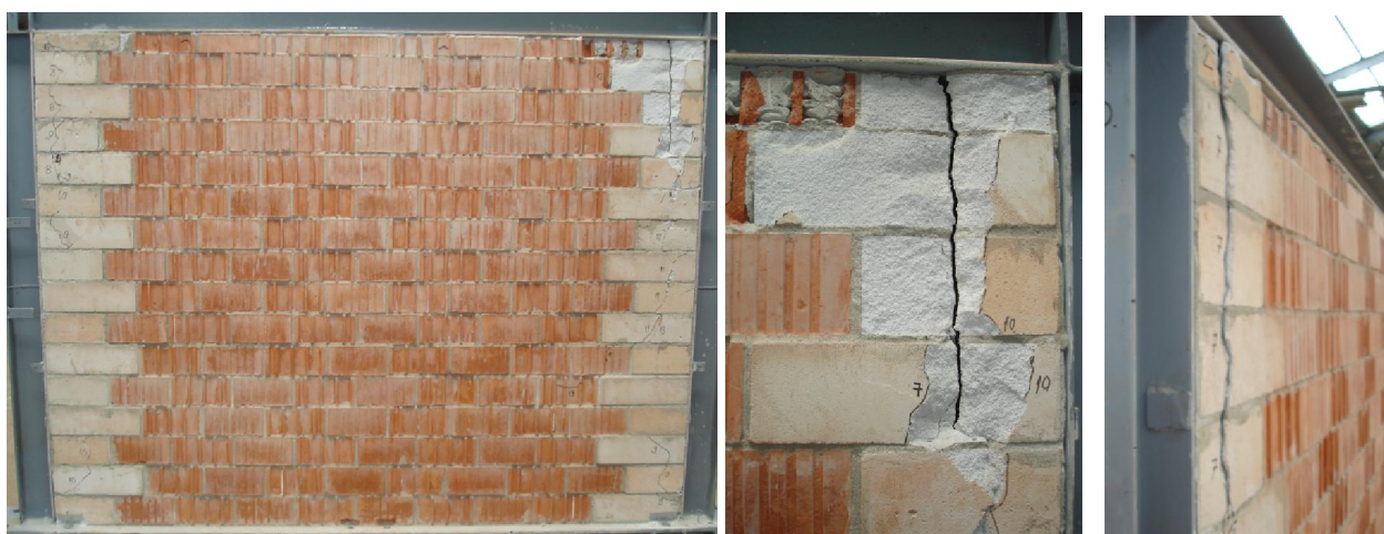
Slika 4.77 – Oštećenja okvira sa zidanim ispunom – OGY-2
