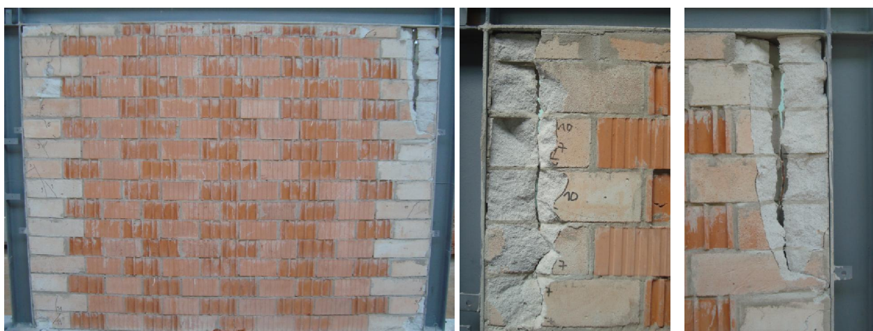
Slika 4.76 – Oštećenja okvira sa zidanim ispunom – OGY-1
