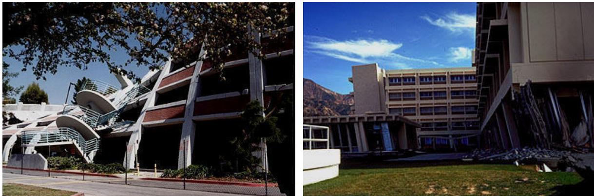
Slika 1. Oštećenja građevina uslijed djelovanja potresa
