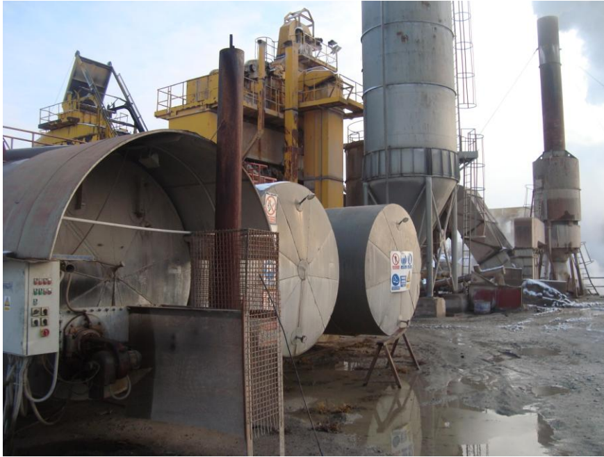
Slika 30. Asfaltno postrojenje u Nemetinu
