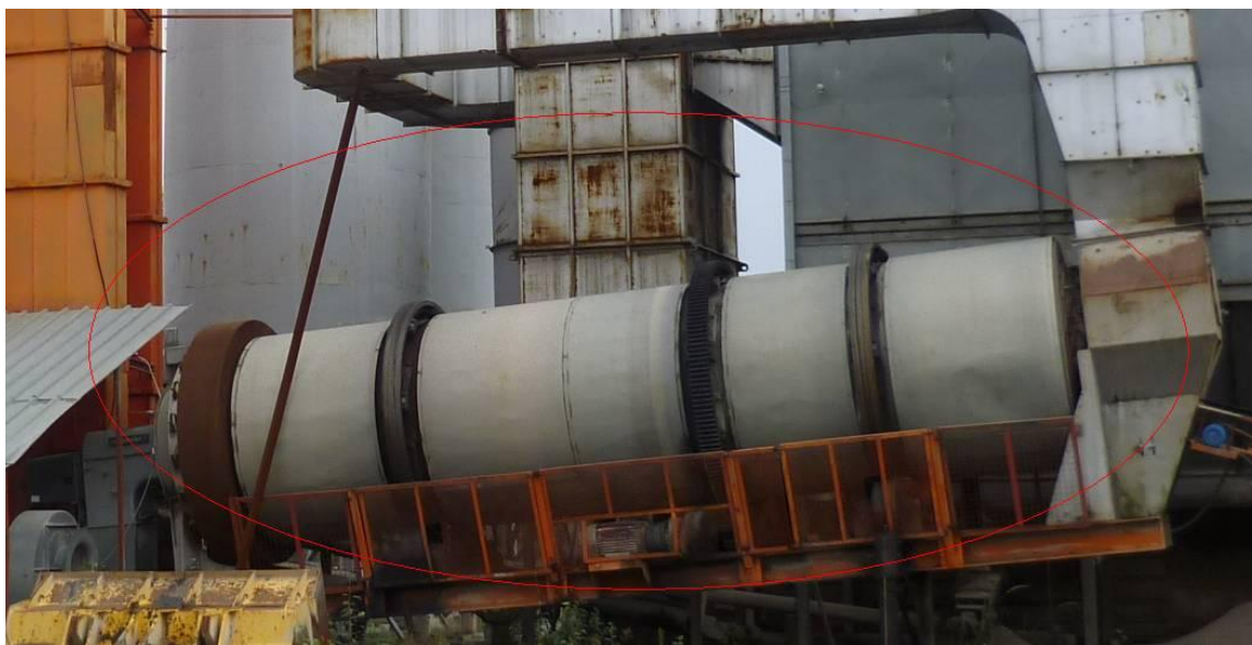
Slika 78. Rotacijski bubanj na asfaltnom postrojenju u Lužanima
