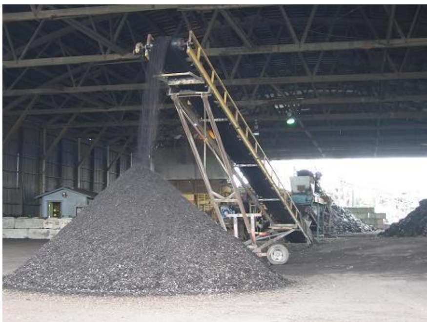
Slika 12. Natkrivena reciklirana asfaltna mješavina [100]
