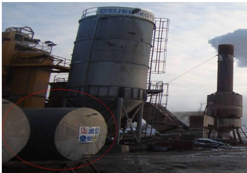
Slika 76. Spremnici za uskladišteni bitumen u Nemetinu
