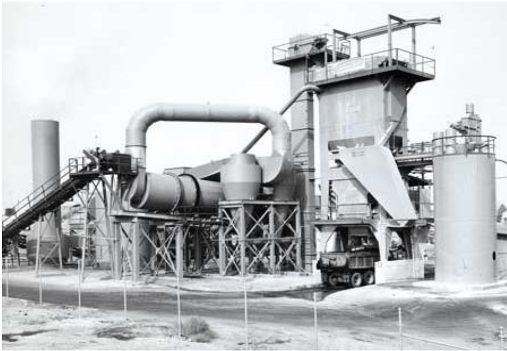
Slika 6. Asfaltno postrojenje iz 60-ih godina 20. stoljeća [44]
