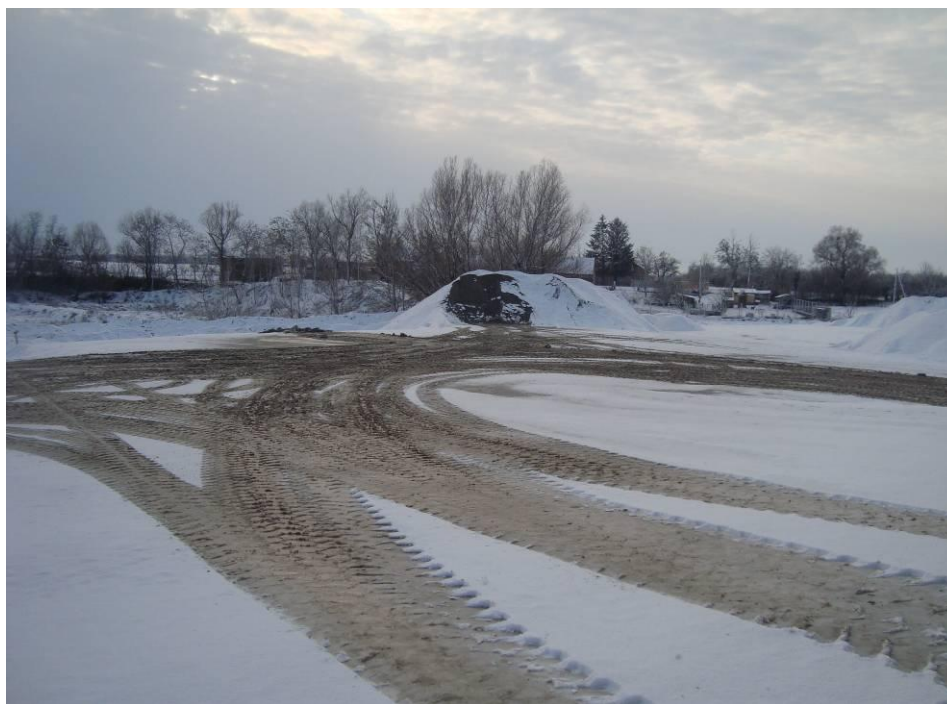
Slika 81. Deponija kamenog agregata na asfaltnom postrojenju u Nemetinu
