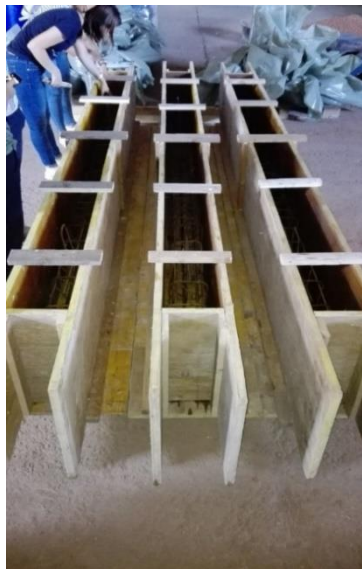
Slika 7.2 Prikaz oplate za AB grede
