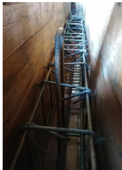
Slika 7.3 Prikaz armature za AB grede
