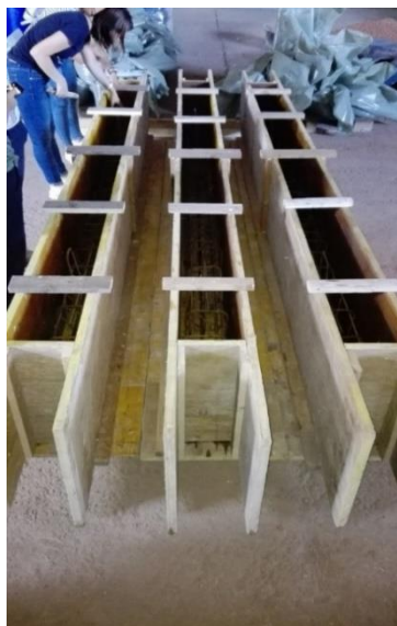
Slika 7.2 Prikaz oplate za AB grede
