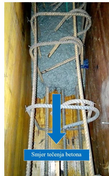
Slika 7.4 Tečenje betona pod djelovanjem vlastite težine
