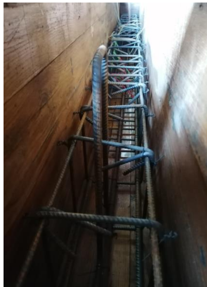
Slika 7.3 Prikaz armature za AB grede
