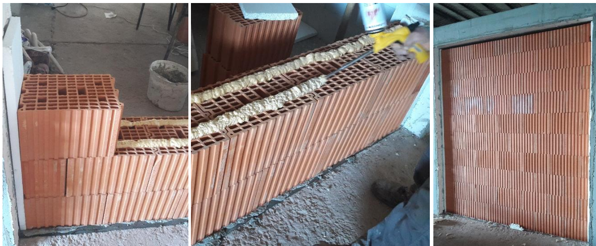
Slika 4.8 Zidanje zida od brušene šuplje blok opeke
