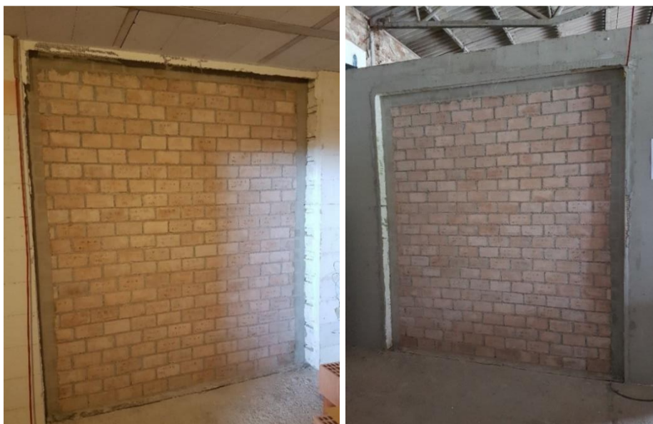
Slika 4.12 Unutarnja (lijevo) i vanjska strana (desno) izvedenog zida od betonskih zidnih elemenata s recikliranom opekom
