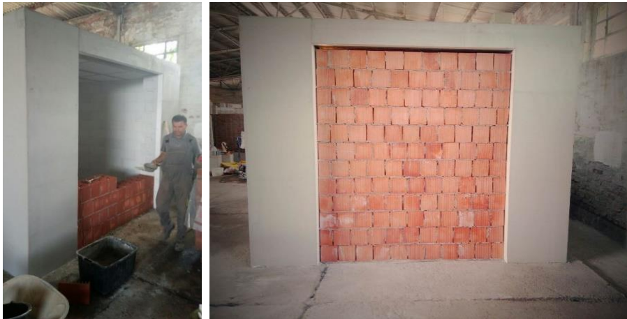
Slika 4.6 Zidanje zida od šuplje blok opeke
