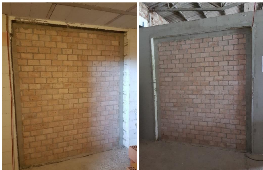
Slika 4.12 Unutarnja (lijevo) i vanjska strana (desno) izvedenog zida od betonskih zidnih elemenata s recikliranom opekom
