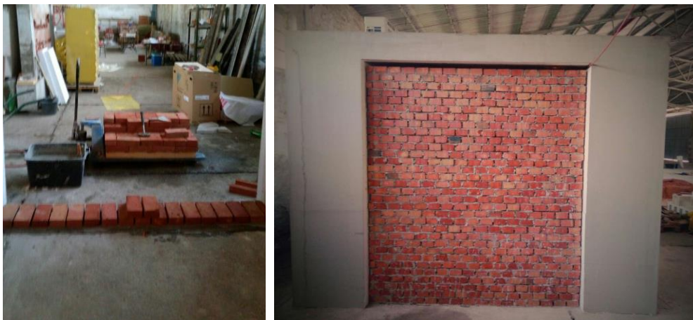
Slika 4.7 Zidanje zida od pune opeke
