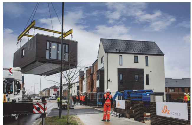
Slika 13. Postavljanje čeličnog modula kuće [24]
