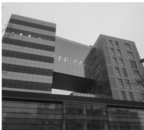
d) novija armirnobetonska zgrada (armirnobetonski okvir)
