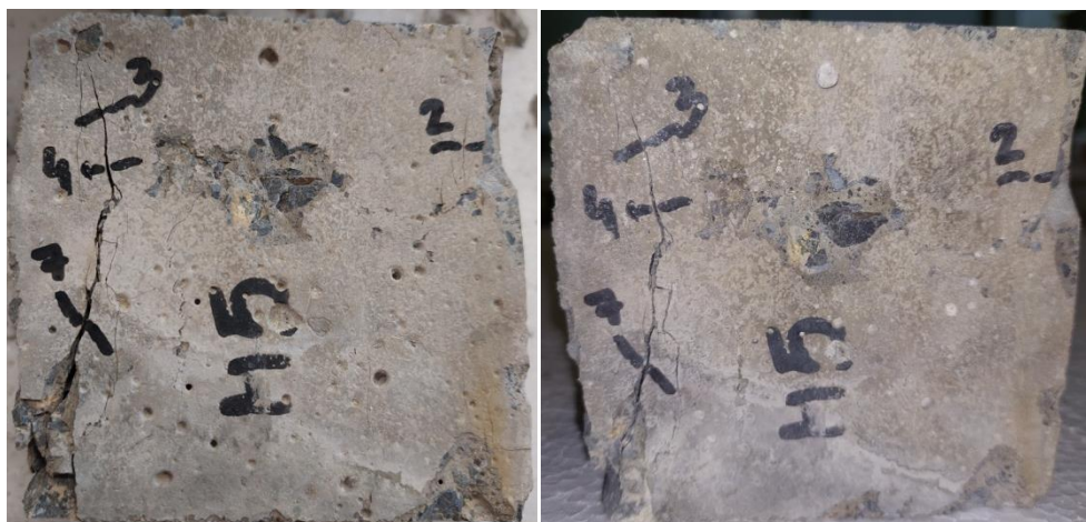
Slika 6.75. Mješavina M5 bez smrzavanja (lijevo – prije samocijeljenja, desno - nakon samocijeljenja)
