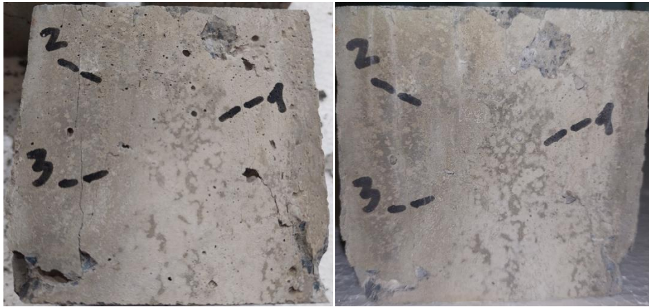
Slika 6.70. Mješavina M2 nakon smrzavanja i odmrzavanja (lijevo – prije samocijeljenja, desno - nakon samocijeljenja)
