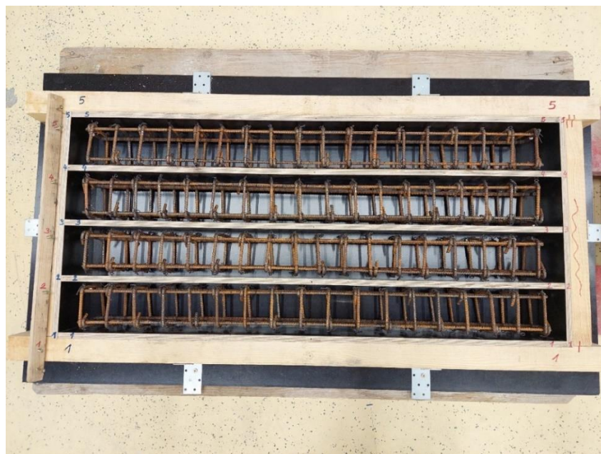
Slika 7.14. Oplata i armaturni koševi gredica
