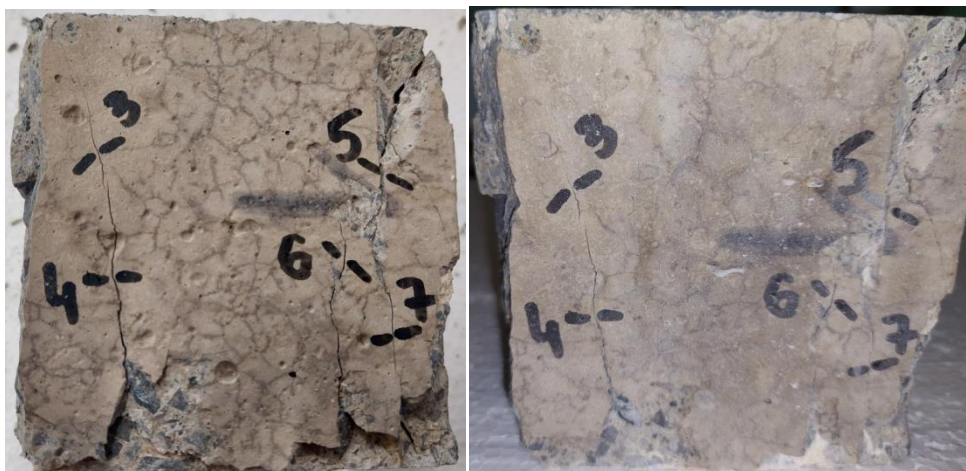
Slika 6.76. Mješavina M5 nakon smrzavanja i odmrzavanja (lijevo – prije samocijeljenja, desno - nakon samocijeljenja)
