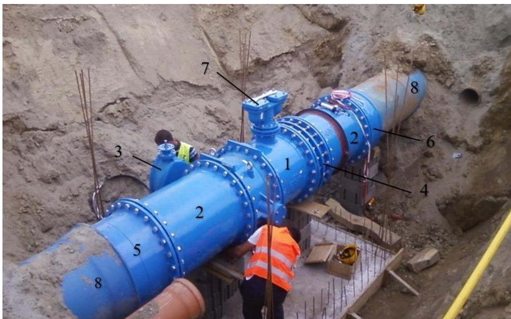
Slika 6.2 Završno slaganje fazonskih komada magistralnog cjevovoda DN 800
