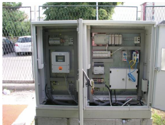
Slika 2. Sustav za kontinuirano praćenje protoka vodoopskrbnog sustava Osijeka
