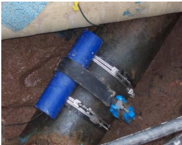
Slika 3. Ugradnja senzora za kontinuirano praćenje protoka [28]
