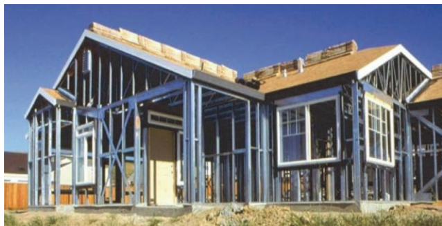
Slika 1. Kuća s čeličnom konstrukcijom [2]
