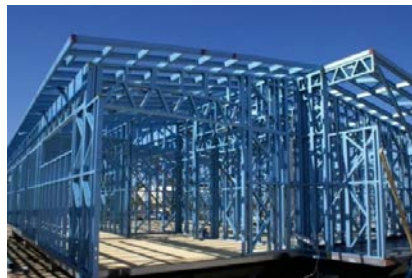
Slika 13. Montažni sustav od metala [21]
