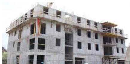
Slika 10. Montažni sustav od betona [17]
