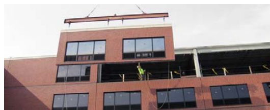
Slika 11. Montažni sustav od opekarskih proizvoda [18]
