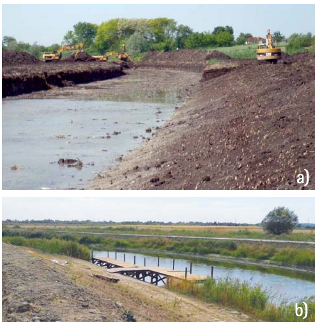
Slika 9: Meandar Laslovo tijekom a) i nakon izvođenja radova b), (fotografija N. Bataković, 2011.)
