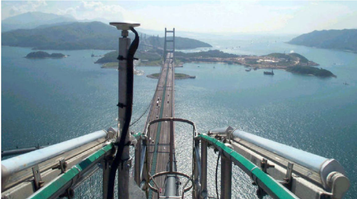
Slika 6 – GPS antena na vrhu pilona
