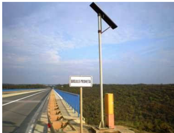
Slika 22 - Automatsko brojilo prometa
