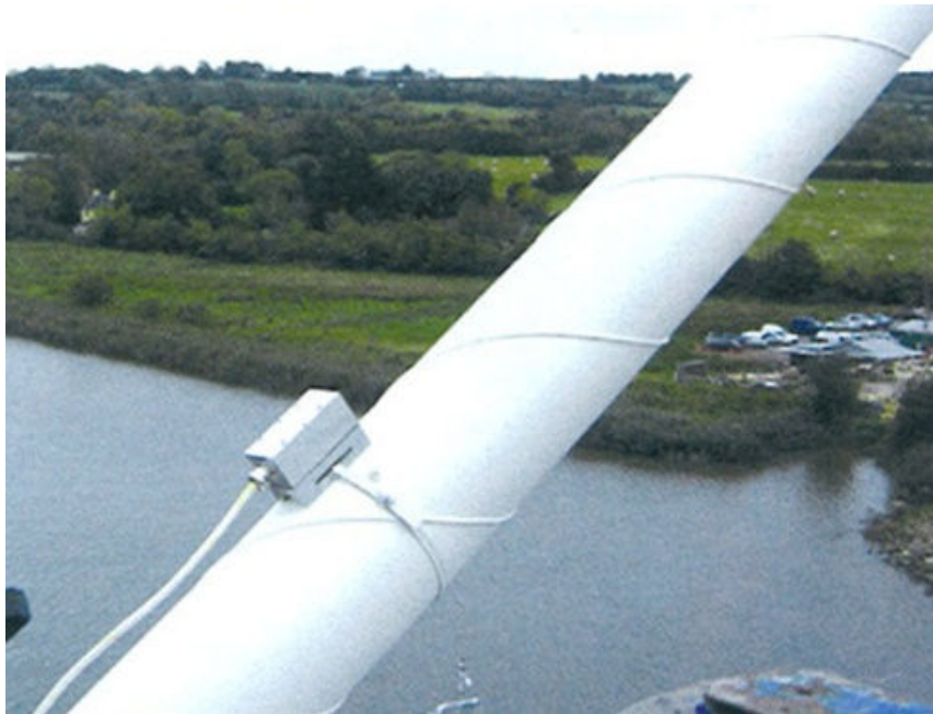
Slika 15 – Akcelerometar pričvršćen za jednu vješaljku
