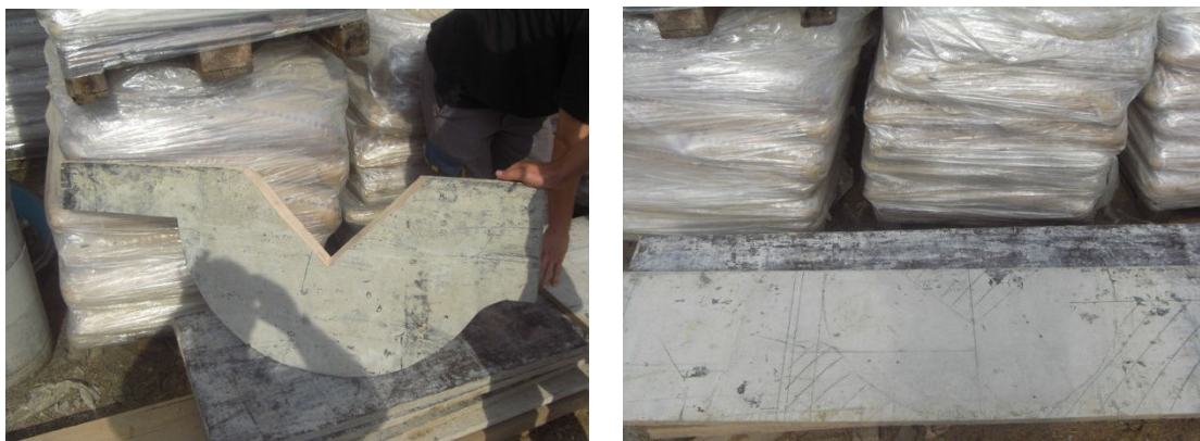
Slika 6 - Izrada trokutnog Thomsonovog preljeva
