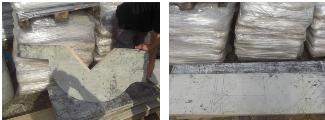
Slika 6 - Izrada trokutnog Thomsonovog preljeva
