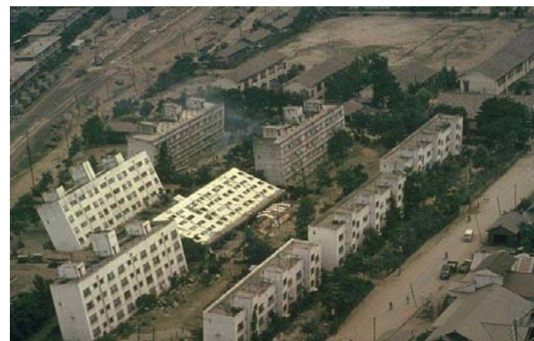
Slika 1 - Posljedice pojave likvefakcije nakon potresa iz 1964. godine: Aljaska (lijevo) [4] i Niigata (desno) [5]
