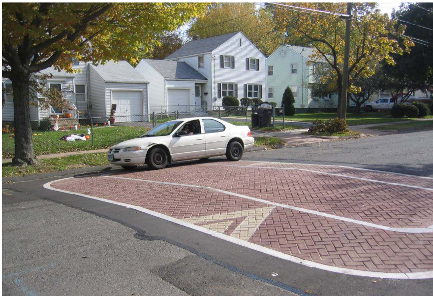
Slika 5 - Izdignuće na kolniku izvedeno kombinacijom asfalta i betonskih elemenata [7]
