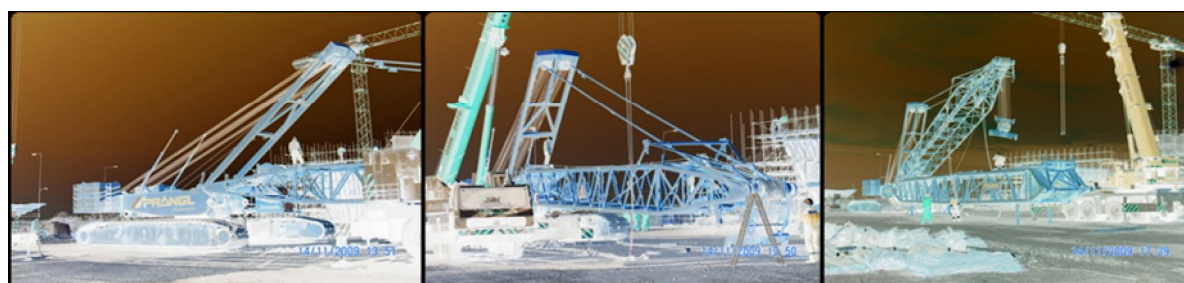
Slika 10 – Demontaža dizalice
