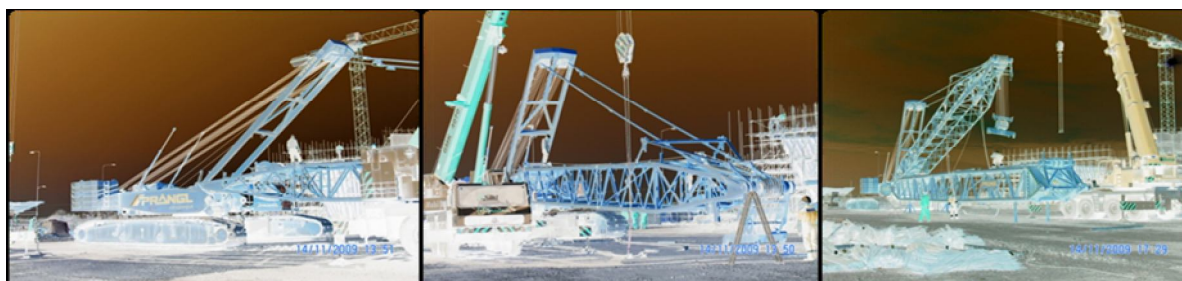
Slika 10 – Demontaža dizalice
