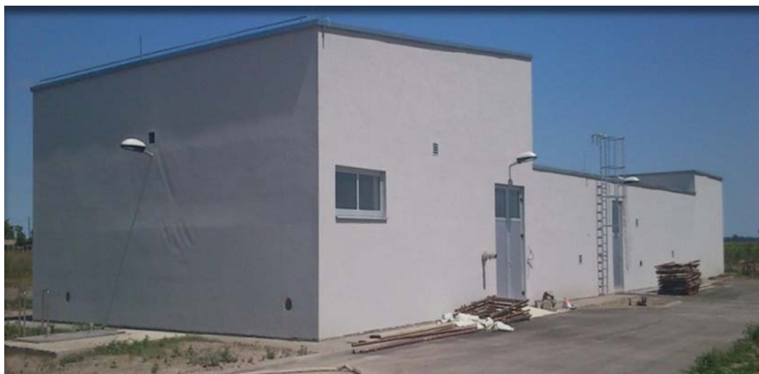
Slika 5 - Pogled na izgrađenu zgradu UPOV-a Kneževi Vinogradi
