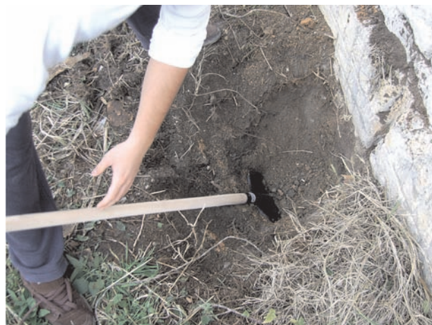
Figure 5 Digging the ground Slika 5 Otkopavanje temelja
