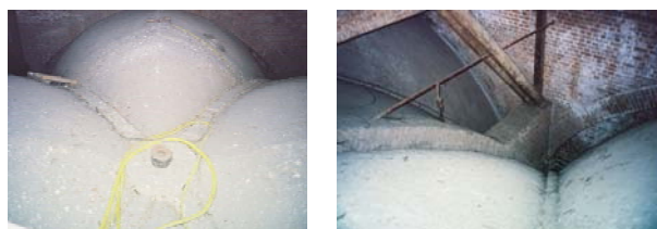
Slika 7. Ekstrados i oslonac svođene konstrukcije
