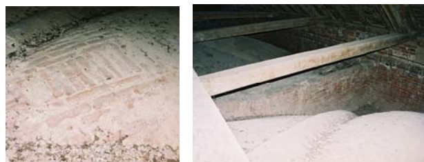
Slika 16. Ekstrados i oslonac svodene konstrukcije
