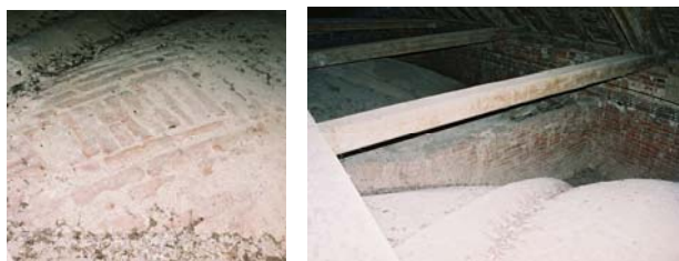
Slika 16. Ekstrados i oslonac svodene konstrukcije
