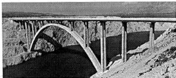
Slika 10. Izgled dovršenoga Masleničkog mosta
