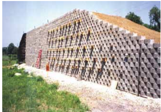
Slika 20. Potporni zid od armiranog tla pripremljen za terenski pokus izvlačenja armature [58]
