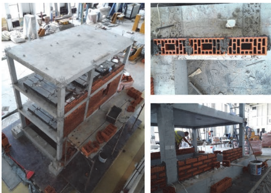
Slika 1. Izvedba šupljeg opečnog ispunskog zida [4]
