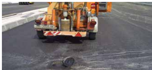
Slika 7. Izvađeni uzorak iz izvedenog sustava hidroizolacija – asfalt na vijaduktu "Odra"
