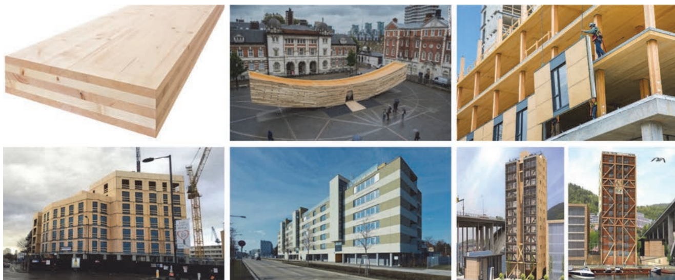
Slika 1. CLT element s 5 slojeva (gore lijevo) [4]; izložbeni paviljon "The Smile" u Londonu (gore u sredini) [4]; projekt "Brock Commons" u Vancouveru (gore desno) [5]; projekt "Dalston Lane" u Londonu (dolje lijevo) [6]; projekt "Wohnbau Wagramer Strasse" u Beču (dolje sredina) [7]; projekt "Treet" u Bergenu (dolje desno) [8]
