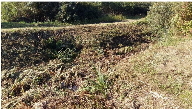
Slika 5.17. Kanal Drobnjak, stac. 2+200
