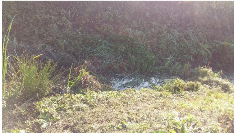
Slika 5.13. Kanal Drobnjak, stac. 0+120
