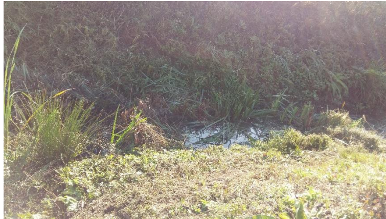
Slika 5.13. Kanal Drobnjak, stac. 0+120
