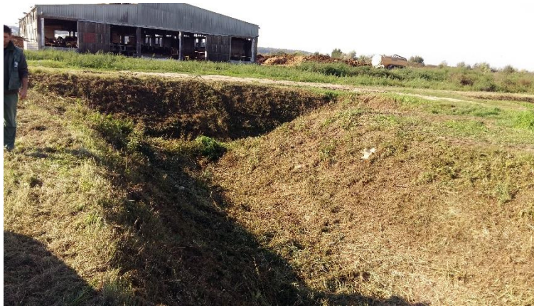
Slika 5.15. Kanal Drobnjak, stac. 1+800
