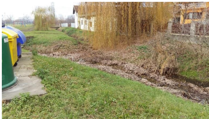
Slika 5.21. Spoj kanala Punovci-Gorjani i kanala Mač
