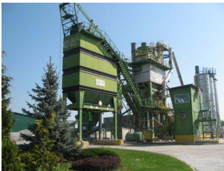
Slika 5-2: Asfaltna baza Lepoglava u Lepoglavi (COLAS Hrvatska d.d.)
