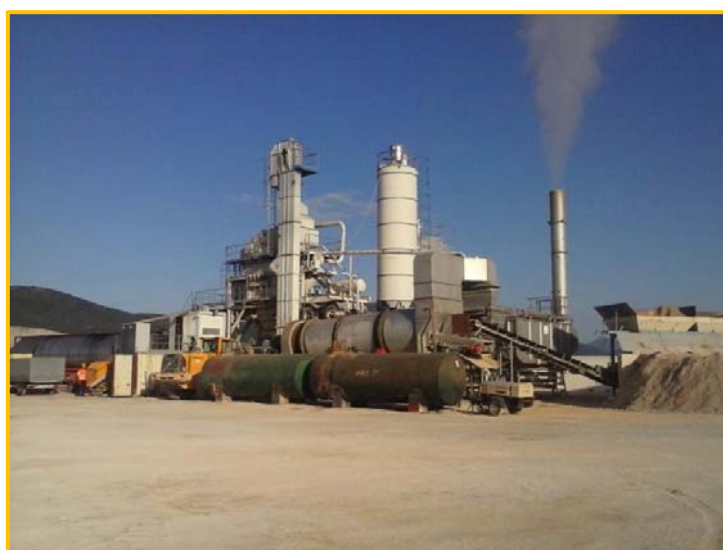
Slika 5-5: Asfaltna baza Ploče u mjestu Kula Norinska (COLAS Hrvatska d.d.)
