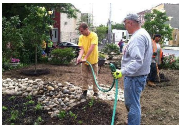
Slika 3. Zamjena vegetacije i zalijevanje kod bioretencija
