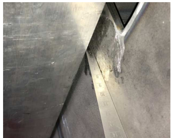
Slika 6. Stub zavaren izvan alata
