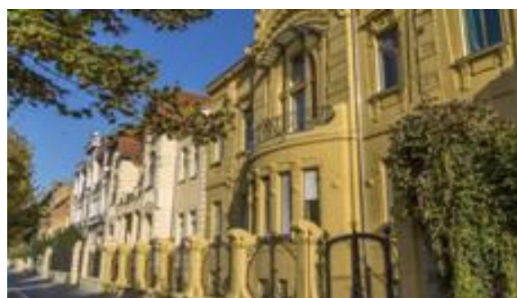
Slika 4. Obnova zgrada - spomenika kulture putem sufinanciranja grada
