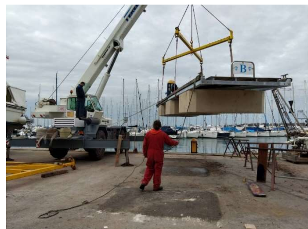
Slika 11. Primjer zamjene oštećenog betonskog uzgonskog elementa i čeličnog okvira
