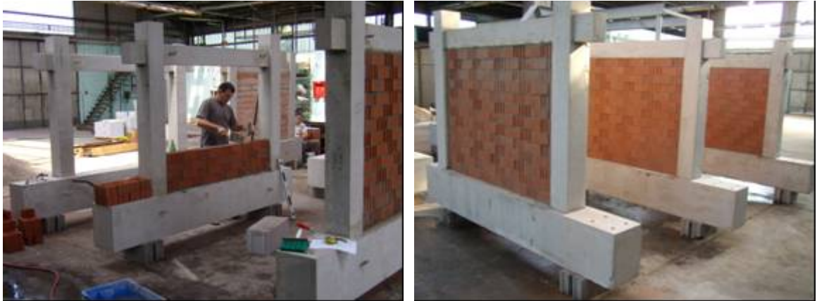
Slika 4.4 Prikaz zidanja zidnog ispuna od opečnih blokova MO10
