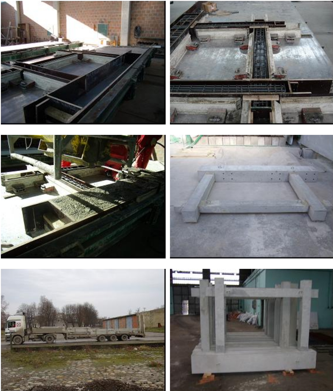
Slika 4.3 Prikaz izrade i dopreme armirano-betonskih okvira modela
