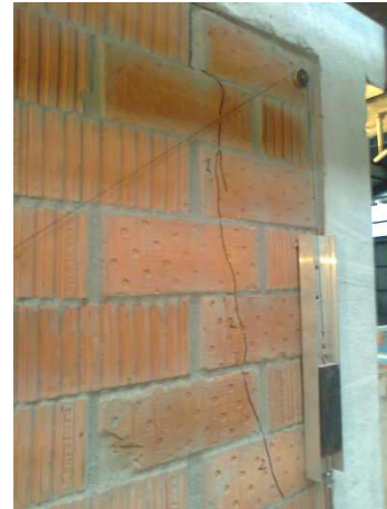
b) Prva značajna pukotina pri negativnom smjeru opterećenja
