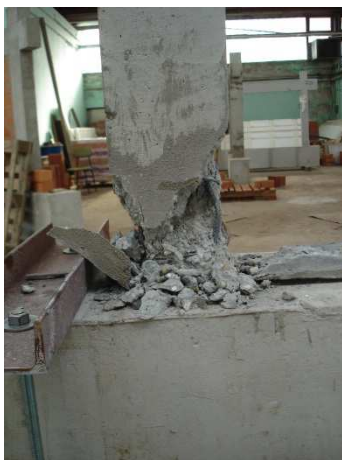
c) Oštećenje lijevog stupa ispitnog uzorka
