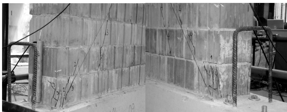
Slika 4.114. Rasprostiranje pukotina po dubini zida uzorka D
