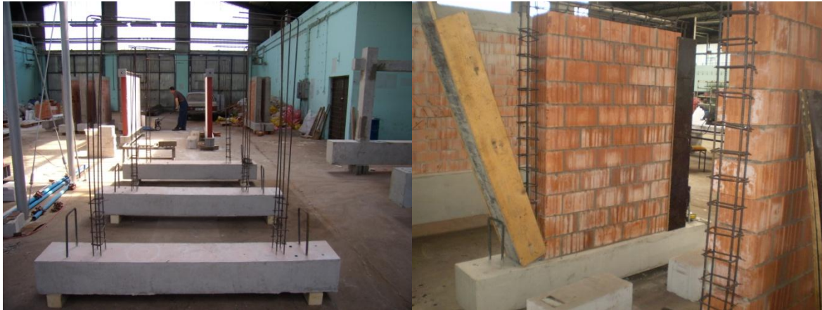
Slika 4.6. Izrada temelja uzoraka, priprema oplata za betoniranje vertikalnih serklaža uzoraka
