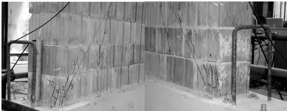
Slika 4.114. Rasprostiranje pukotina po dubini zida uzorka D
