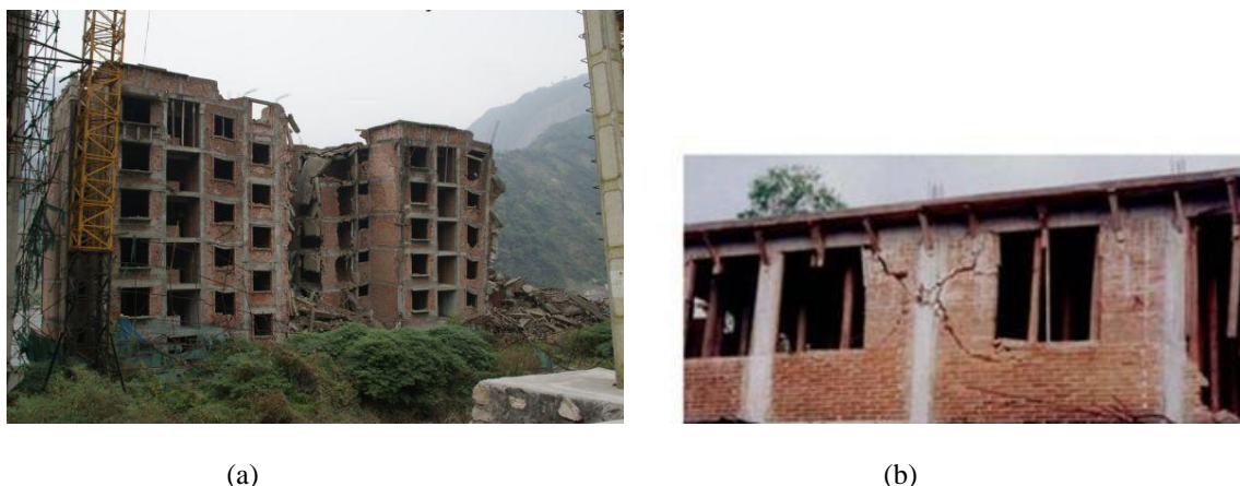
Slika 2.4. Fotografija stambene zgrade u Kini uništene 2008. potresom u pokrajini Beichuan (a) i u Meksiku oštećena Tehuacan potresom 1999.god.(b)
