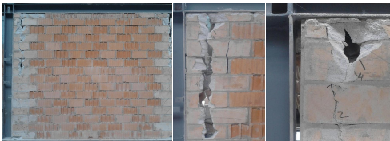
Slika 4.78 – Oštećenja okvira sa zidanim ispunom – OGY-3
