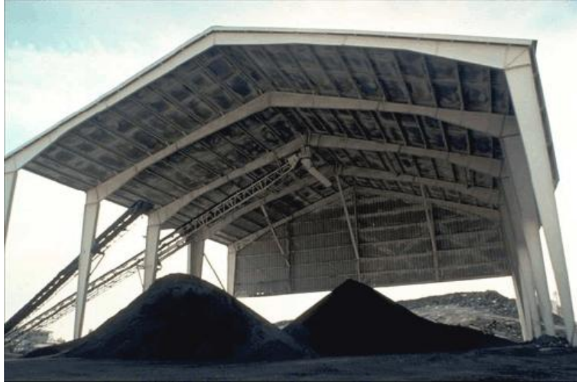
Slika 11. Natkrivena deponija recikliranog asfalta [99]
