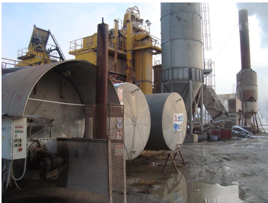
Slika 30. Asfaltno postrojenje u Nemetinu
