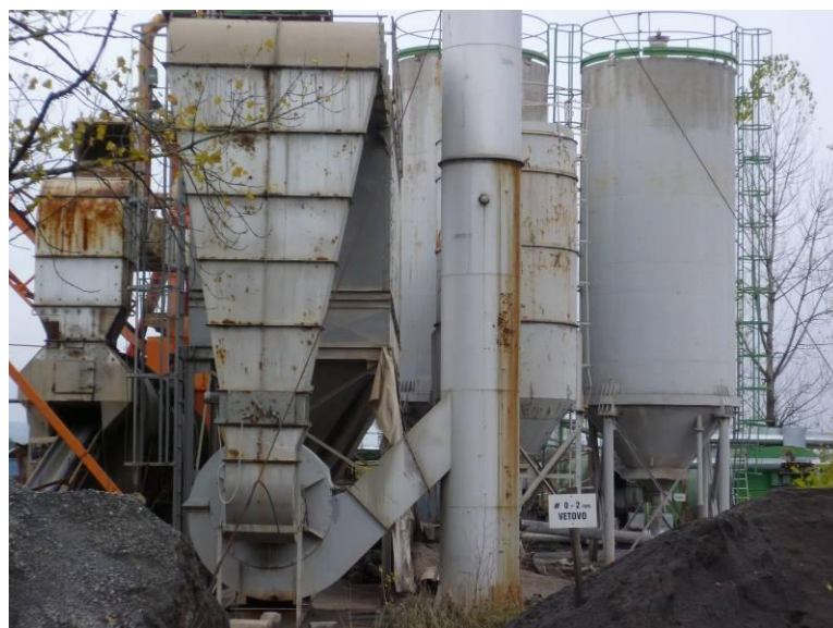
Slika 79. Dimnjak za odvod ispušnih plinova na asfaltnom postrojenju u Lužanima
