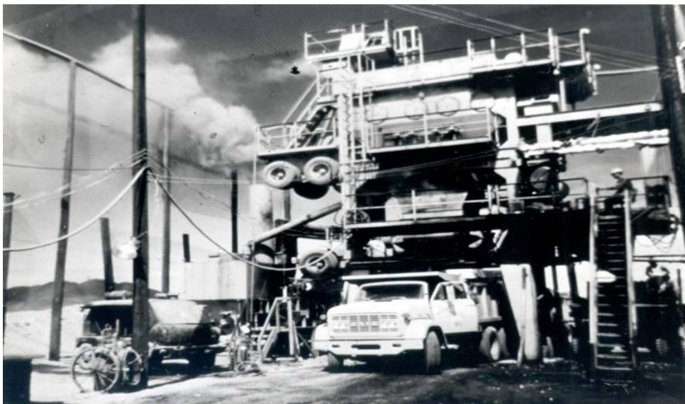
Slika 7. Asfaltno postrojenje iz 1965. godine [44]
