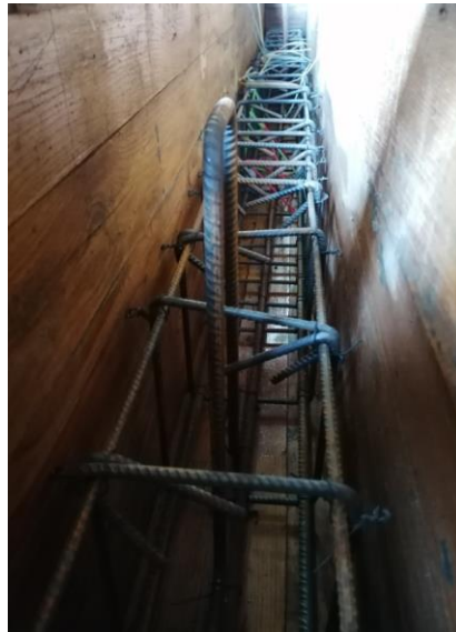
Slika 7.3 Prikaz armature za AB grede
