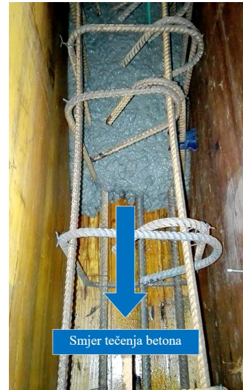
Slika 7.4 Tečenje betona pod djelovanjem vlastite težine
