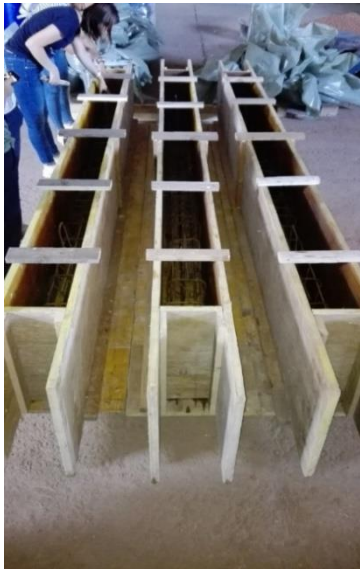
Slika 7.2 Prikaz oplate za AB grede
