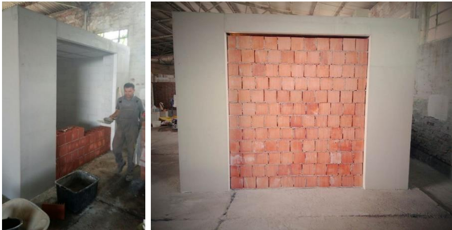
Slika 4.6 Zidanje zida od šuplje blok opeke
