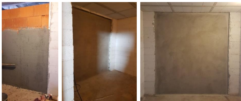
Slika 4.3 Prikaz izvedbe unutarnjeg sloja žbuke
