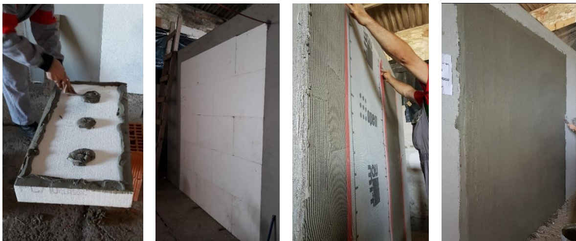
Slika 4.4 Postavljanje toplinske izolacije od ekspaniranog polistirena
