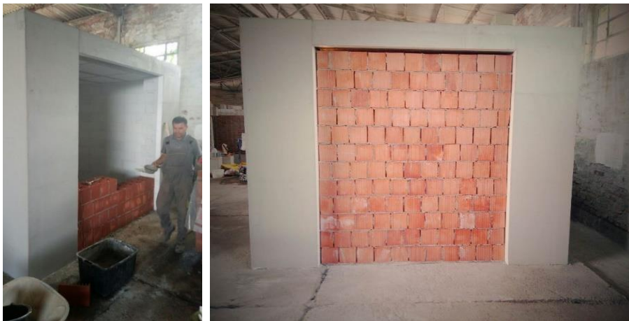
Slika 4.6 Zidanje zida od šuplje blok opeke
