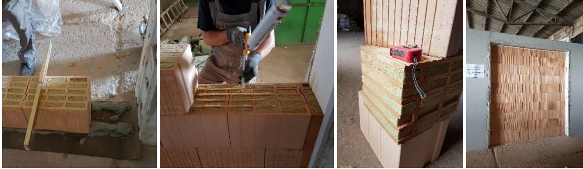
Slika 4.9 Zidanje zida od brušene šuplje blok opeke s integriranom toplinskom izolacijom od kamene vune
