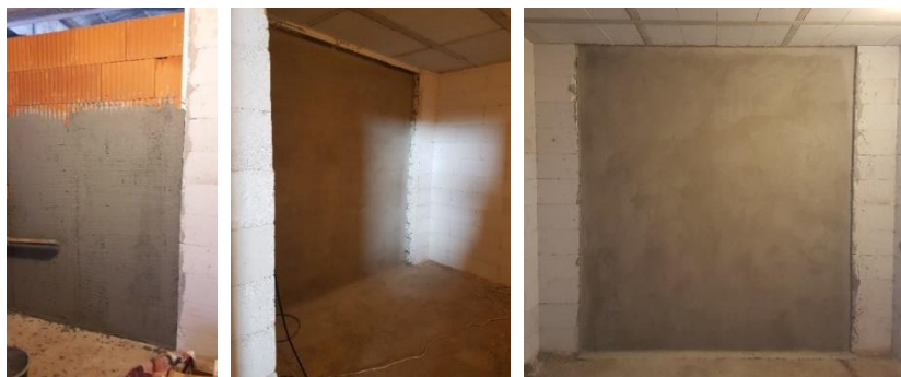
Slika 4.3 Prikaz izvedbe unutarnjeg sloja žbuke
