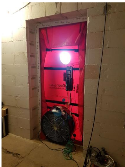
Slika 9.2 Oprema za ispitivanje zrakopropusnosti komore Blower door metodom
