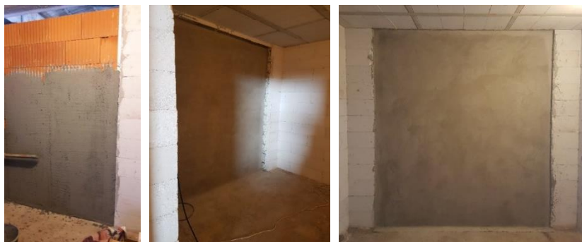
Slika 4.3 Prikaz izvedbe unutarnjeg sloja žbuke
