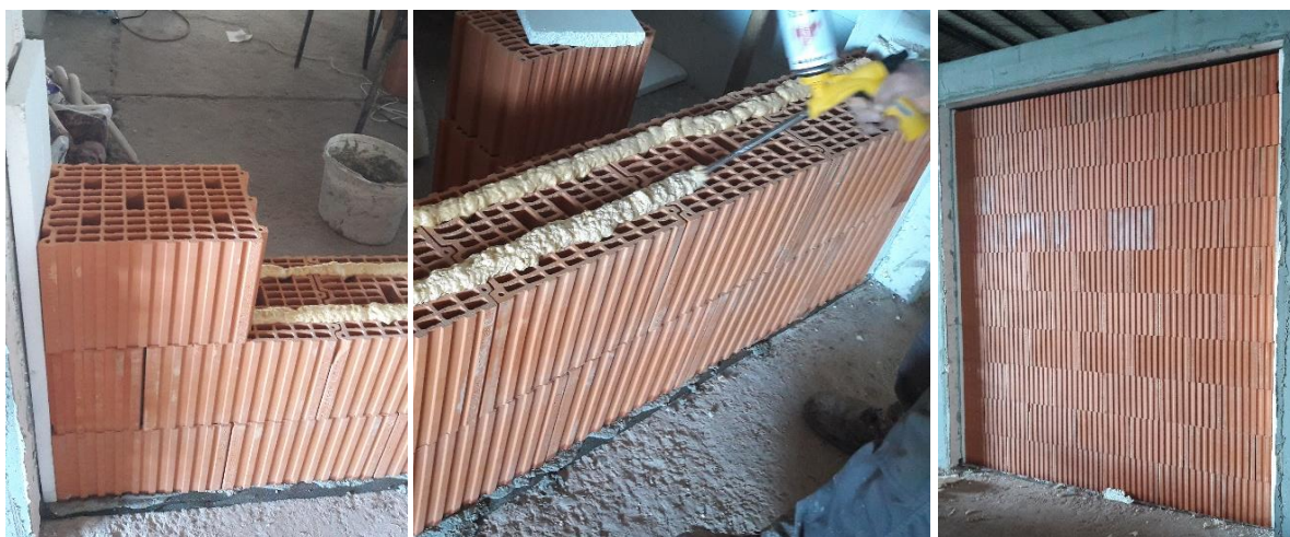
Slika 4.8 Zidanje zida od brušene šuplje blok opeke
