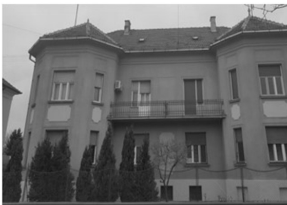
a) starija zidana zgrada – nearmirano ziđe, fleksibilan (drveni) strop
