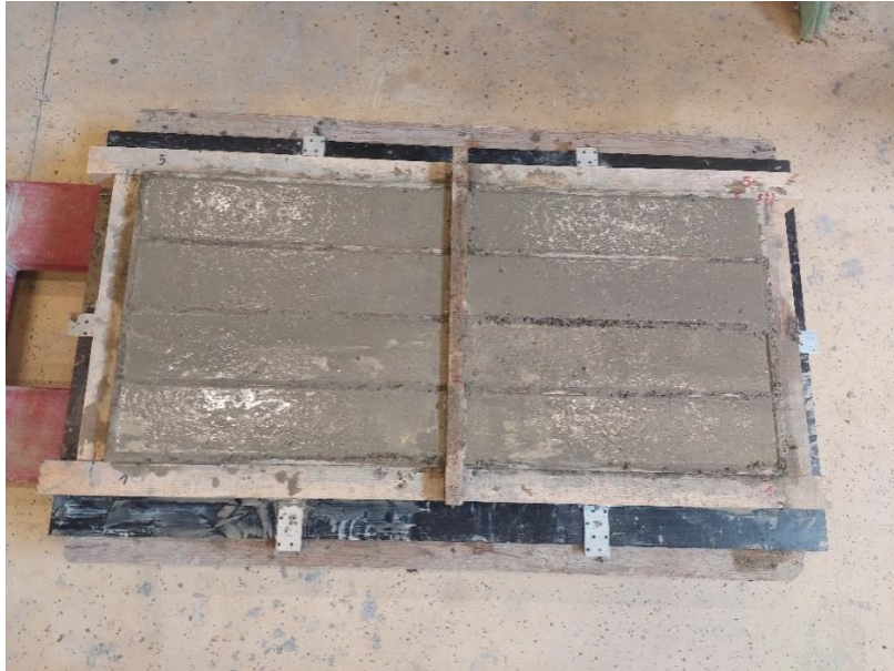
Slika 7.15. Svježi beton u oplati
