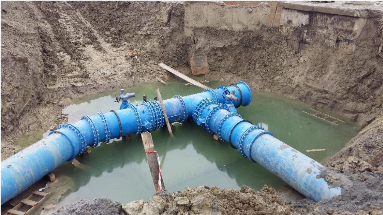
Slika 6.8 Čvorište s postavljenim fazonskim komadima i armaturama; vidljiva podzemna voda unutar građevne jame [10]
