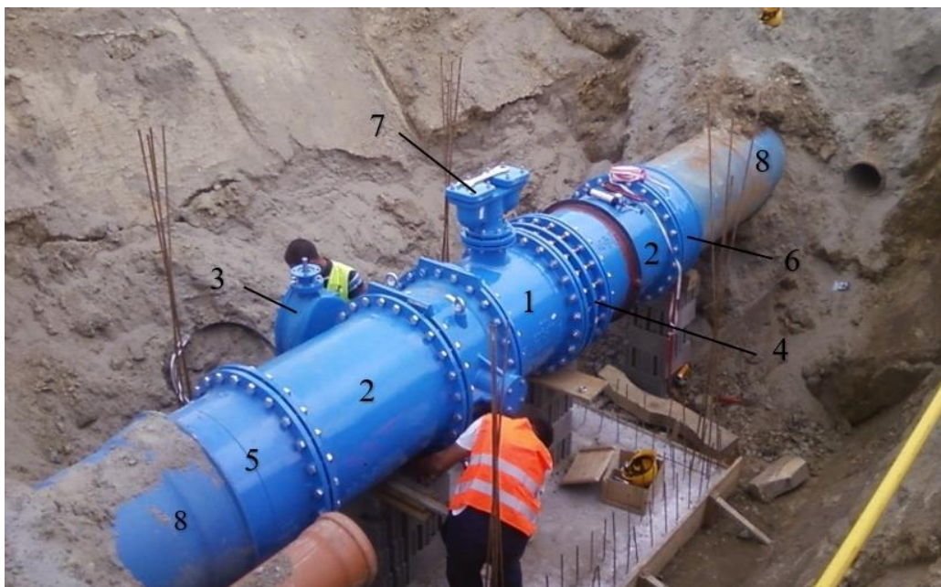
Slika 6.2 Završno slaganje fazonskih komada magistralnog cjevovoda DN 800
