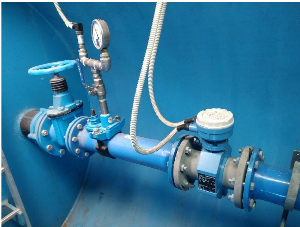
Slika 6.16 Unutrašnjost PEHD okna u koje su smješteni EV zasun mjerači tlaka i protoka spojeni na nadzorno upravljački sustav vodoopskrbe [11]
