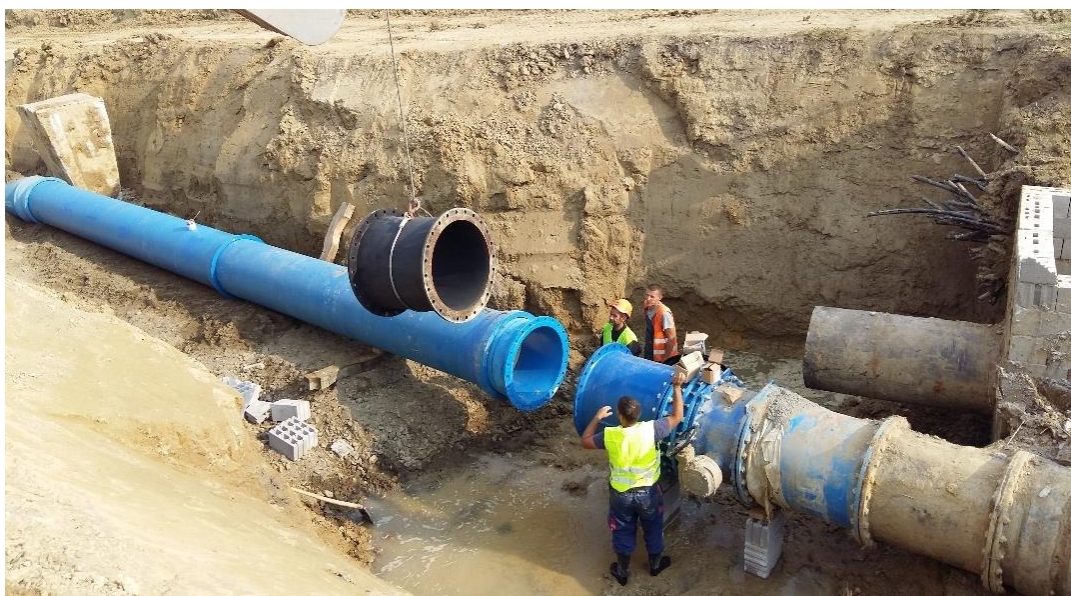
Slika 6.11 Polaganje duktilne cijevi u širokom rovu i povezivanja dionica cjevovoda s FF i MDK komadom [10]
