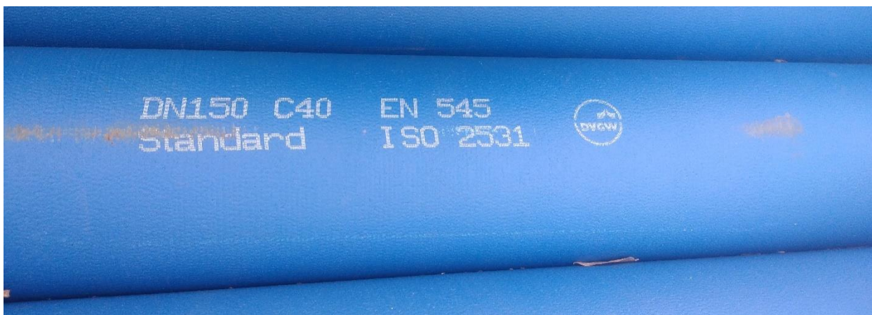
Slika 3.4 Primjer duktilne cijevi s oznakama
