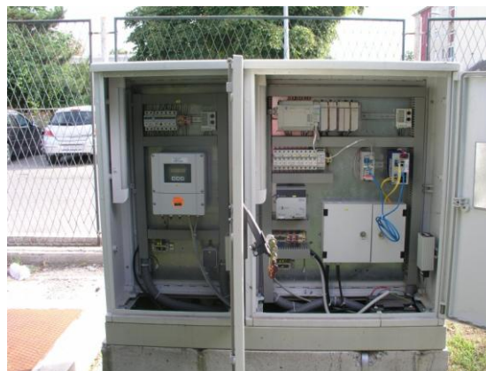
Slika 2. Sustav za kontinuirano praćenje protoka vodoopskrbnog sustava Osijeka
