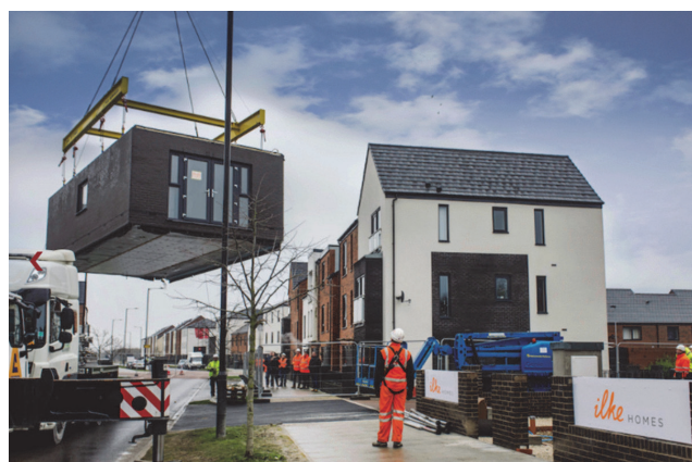
Slika 13. Postavljanje čeličnog modula kuće [24]
