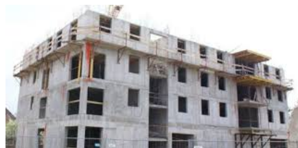
Slika 10. Montažni sustav od betona [17]
