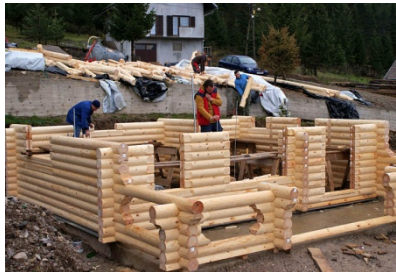
Slika 12. Montažni sustav od drva [19]
